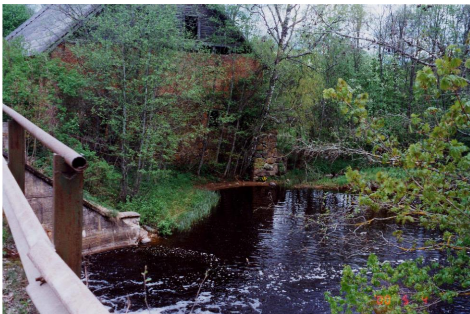
Joon. 2.3.10.6. Vaade maantee sillalt vesiveski alaveele
