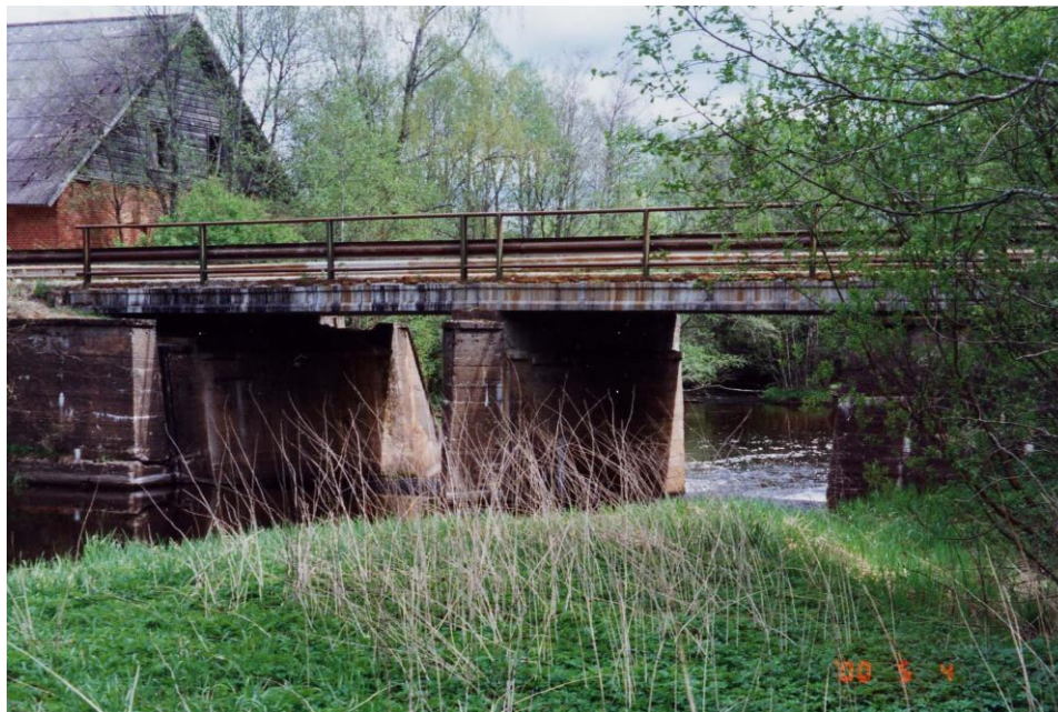
Joon. 2.3.10.4. Koorküla vesiveski ülevoolupais-maantee-sild on väga hästi säilinud
