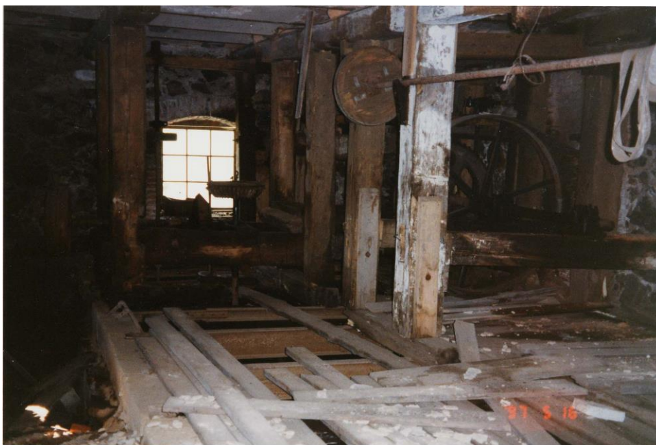
Joon. 2.3.5.2. Veejõujaama sisevaade enne koristamist - taamal on näha ajaloolised veski jõuülekandeajamid.
