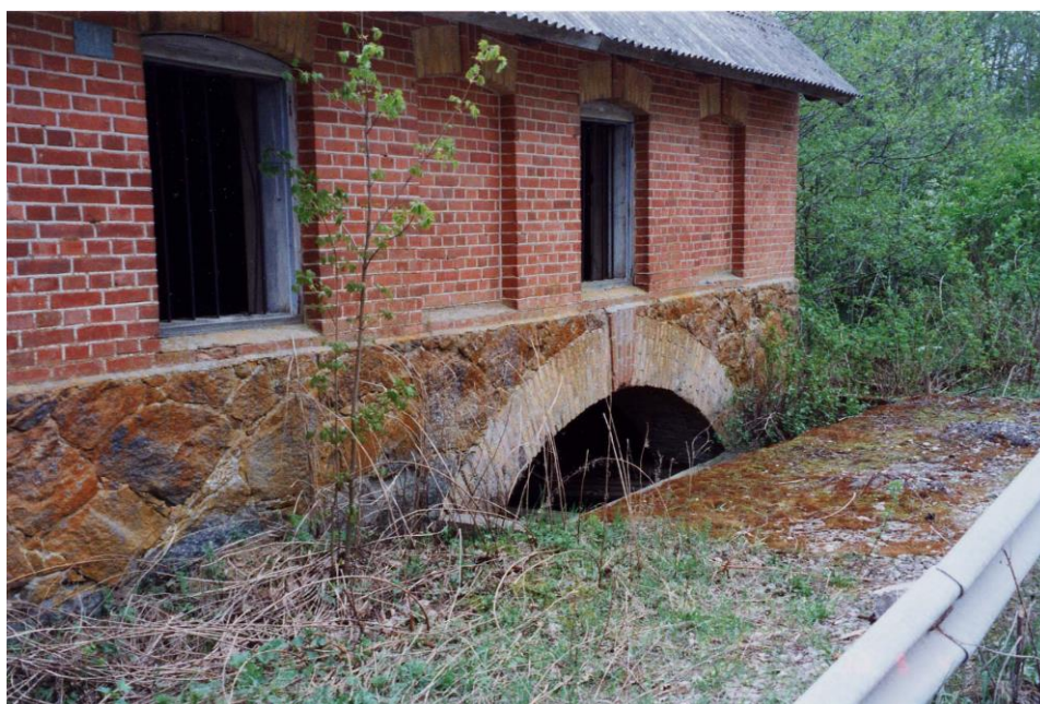
Joon. 2.3.10.3. Turbiinikanali sissevoolusuue, vaade maanteelt - lugupidamisväärselt hästi on ehitus
