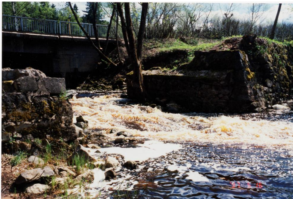
Foto 1 Tõrva veski ülevoolupais kevadsuurvee ajal, esiplaanil vana paisu sillapead, taamal uus
